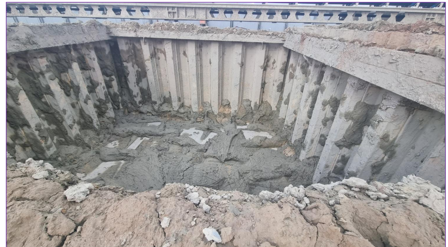
Figure 2 : Photographie de marins de tunnelier en sortie d'excavation (INGÉROP, Mars 2023)
