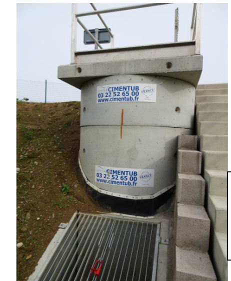
Ouvrage de sortie
