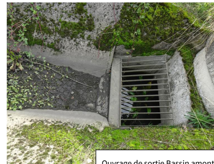
Ouvrage de sortie Bassin amont
