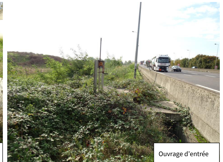
Vue depuis l'aval
