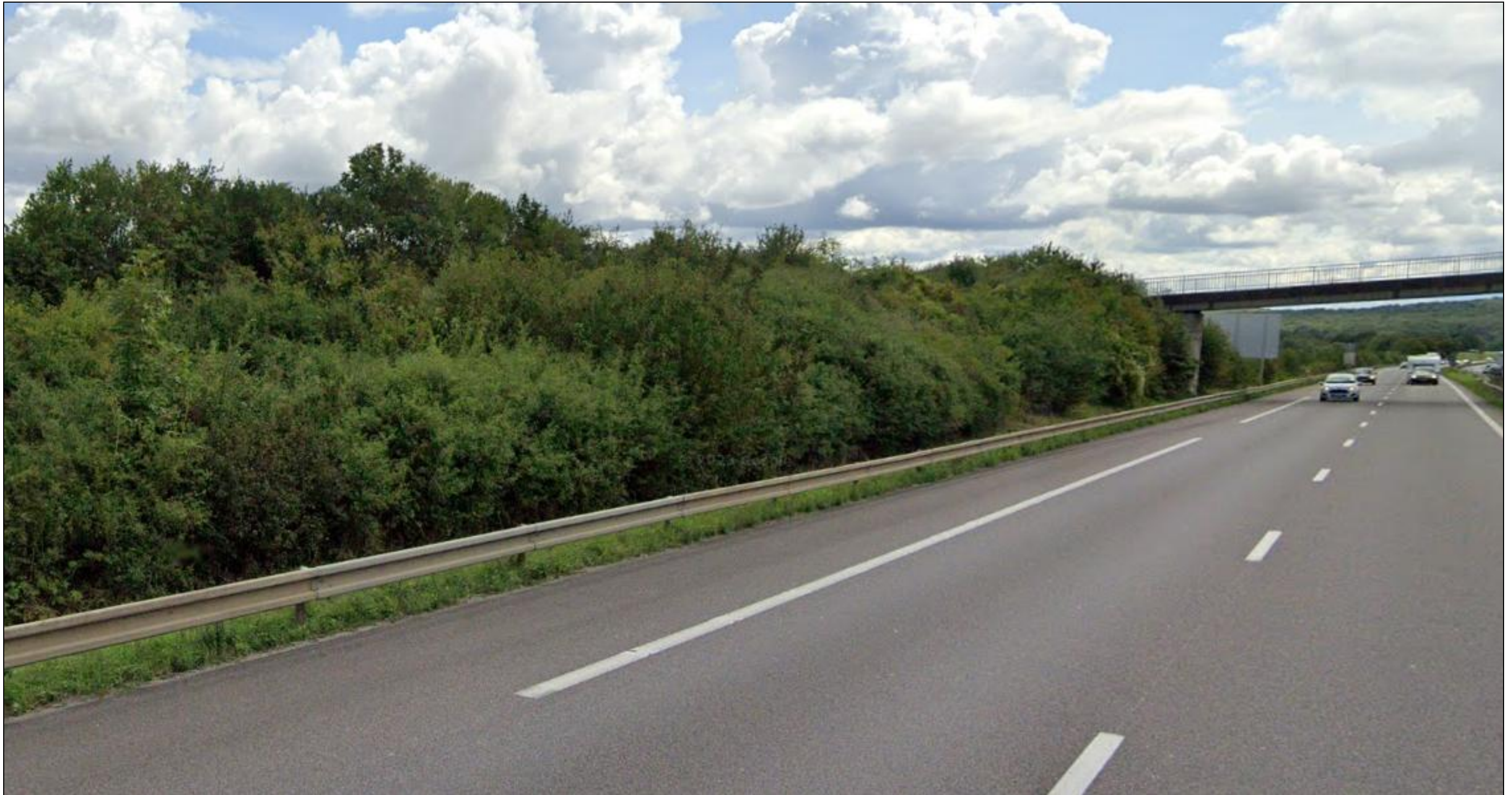
Figure 10 : Vues de la Nzh et des éléments du paysage à protéger du PLU d'Entringe, entre l'intersection de « l'A31 avec la D57A » et l'intersection de « l'A31 avec la rue de la Forêt » (au Sud) (Source : Ingérop, 19/02/2024)
