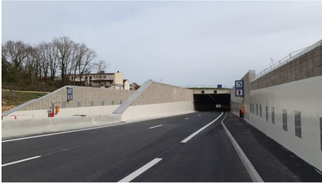
Figure 43 : Tranchée ouverte et couverte de Marange Silvange (RD652, ex-RN52) (57)
