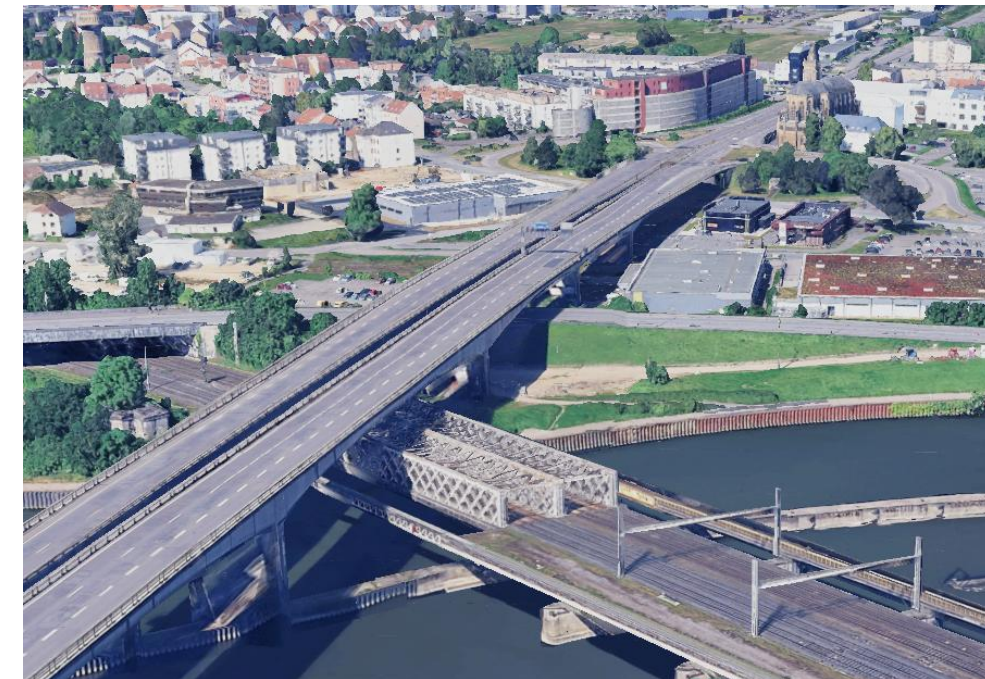
Figure 50 : Illustrations des contraintes latérales pesant sur l'A31 (source : Google Maps)
