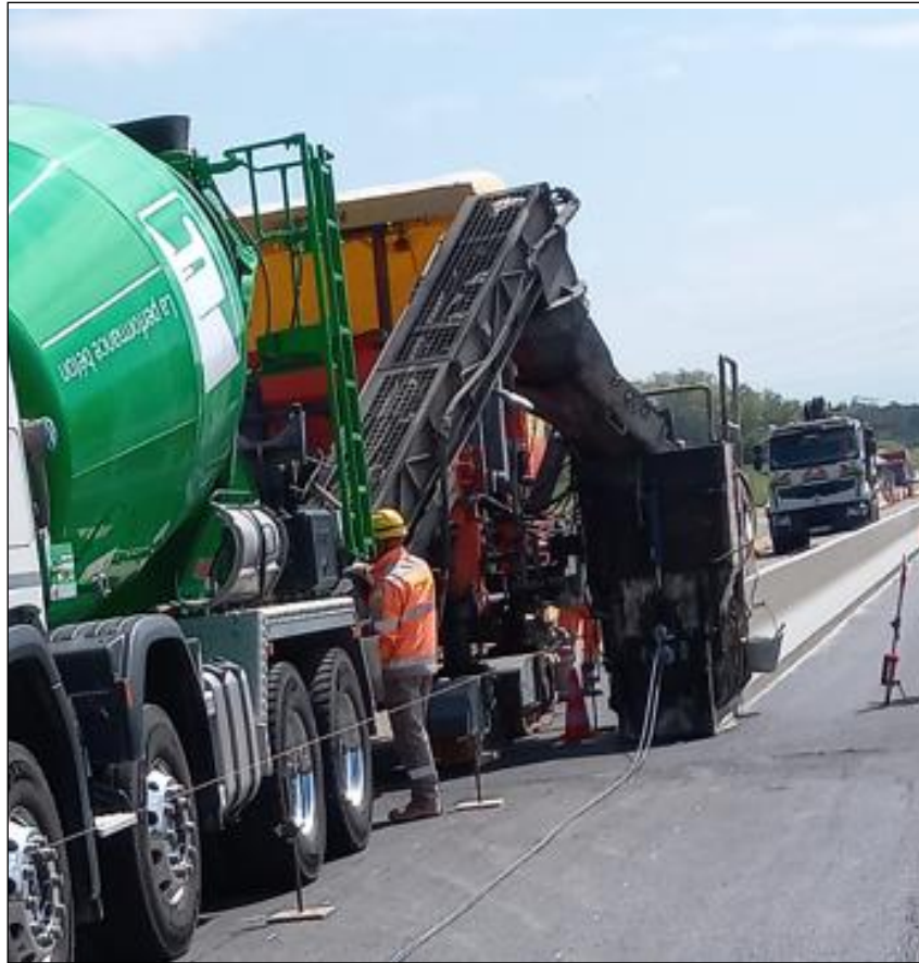
Figure 45 : Création de Glissière en béton adhérent sur un chantier autoroutier
