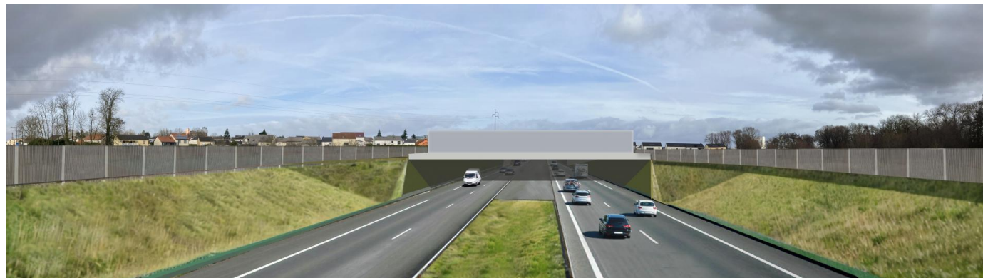
Figure 26 – Vue entrée section souterraine - Tête sud depuis Fameck
