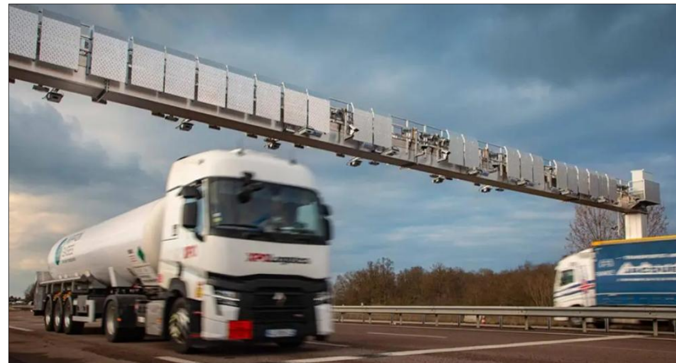
Figure 52 : Exemple de péage en « flux libre » sur l'autoroute A13
