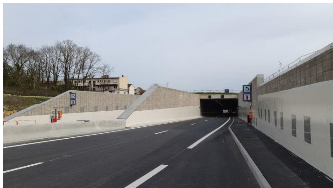
Figure 48 : Tranchée ouverte et couverte de Marange Silvange (RD652, ex-RN52) (57)
