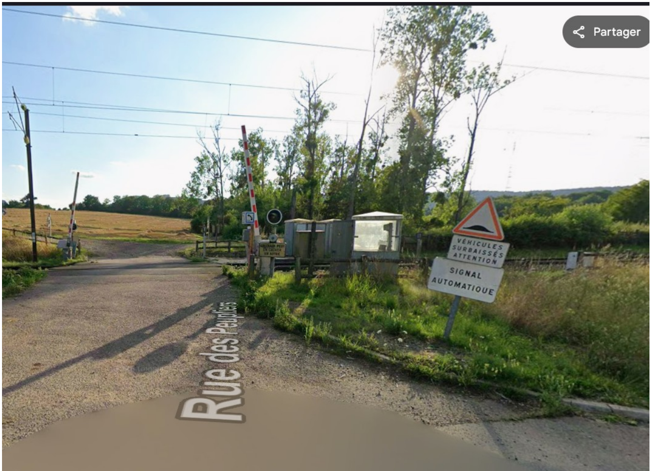
Figure 17: Photo du passage à niveau de Zoufftgen, qui pourrait devenir une gare ou une halte, et qui est indiqué comme étant une gare sur le plan TEMOB. Ce passage à niveau est situé Rue des Peupliers. Source: Google Street View
